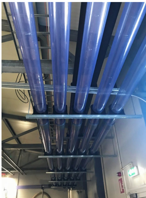
Figur 2: Rørsystem for flytting av fisk.
