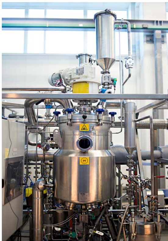
Foto: SINTEFs raffineringsanlegg for marine oljer
