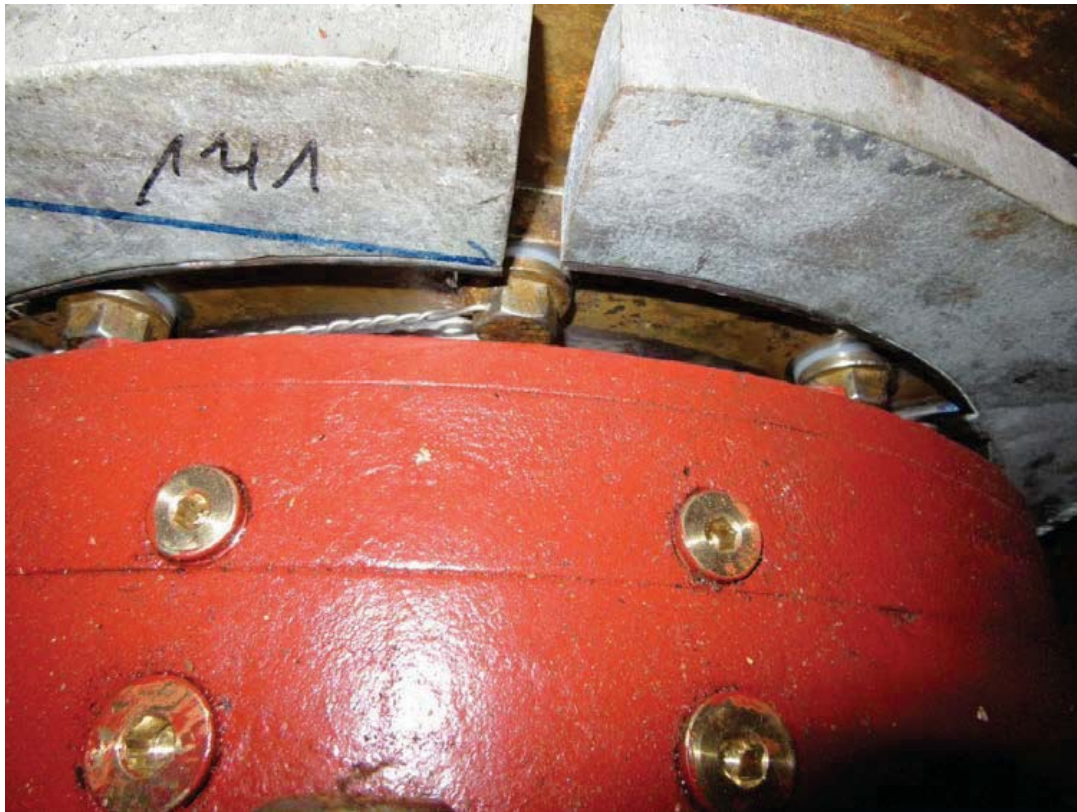
Figur 22. Reparert hylsetetning med sinkanoder
