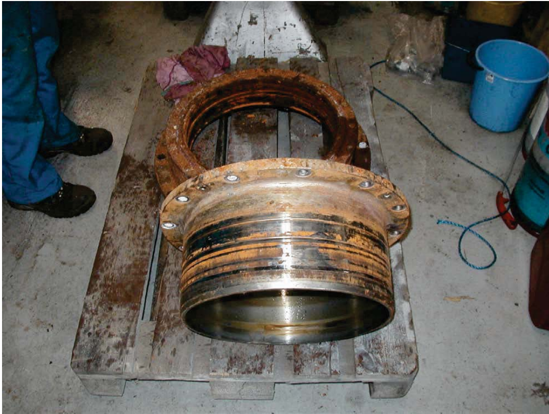
Figur 20. Eksempel på korrodert hylsetetningsboks og slitt liner
