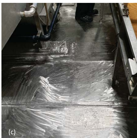
Figur 31. Bildene a)-c) viser rustfritt dekk etter rengjøring og nøytralisering
