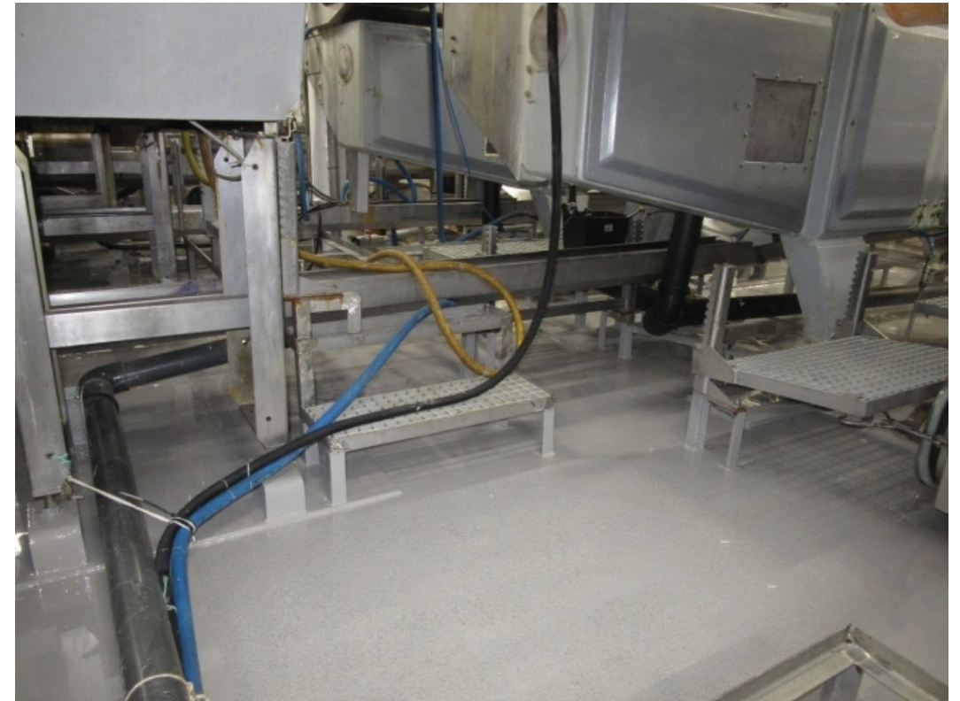
Nymalt fabrikkdekk i karbonstål med malte rustfrie ben og festeplater
