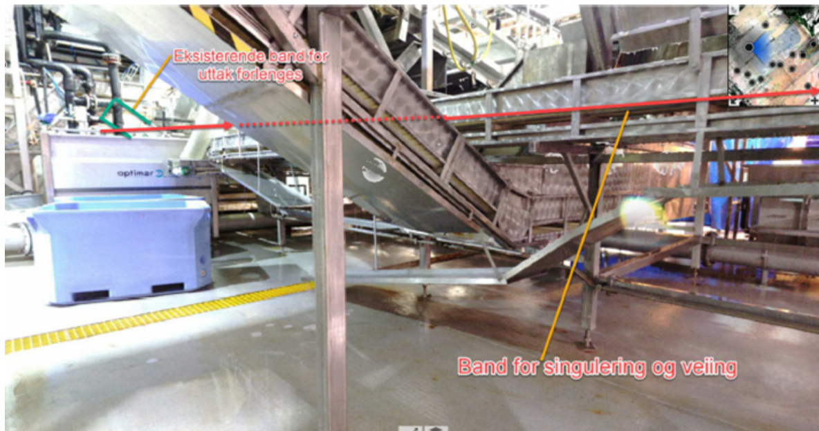
Figur 4. Bilde fra anlegg og pilotinstallasjon.
