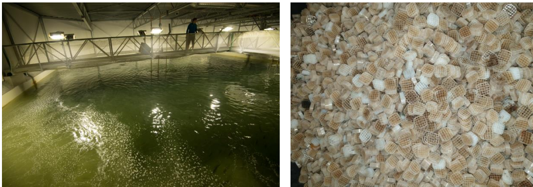
Figur 1. Det marine RAS anlegget til Erko Settefisk AS består av 4 kar med en kapasitet på 125.000 post-smolt laks hver (venstre). Modulen inneholder også 2 biofiltre som er tilknyttet to kar hver, der mikrobiell aktivitet bidrar til å forbedre vannkvaliteten ved å fjerne ammonium og organisk materiale i vannet. Ulike bakterier danner en biofilm med kompleks samfunnsstruktur på plastterningene i biofilteret (høyre). Foto: Karine Drønen og Irene Roalkvam.
