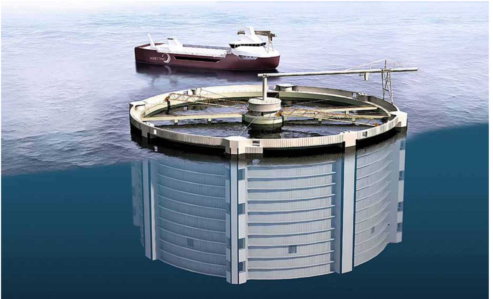
Seafarming Systems i Stavanger arbeider med et opplegg hvor smolt holdes i lukket anlegg til den er stor nok til bedre å tåle sykdom og kan flyttes over i en enorm oppdrettsmerd med diameter på 120 meter som rommer 500.000 kubikkmeter vann. Slike løsninger er der oppdrettsnæringen er kommet lengst, skriver Bård Misund.
