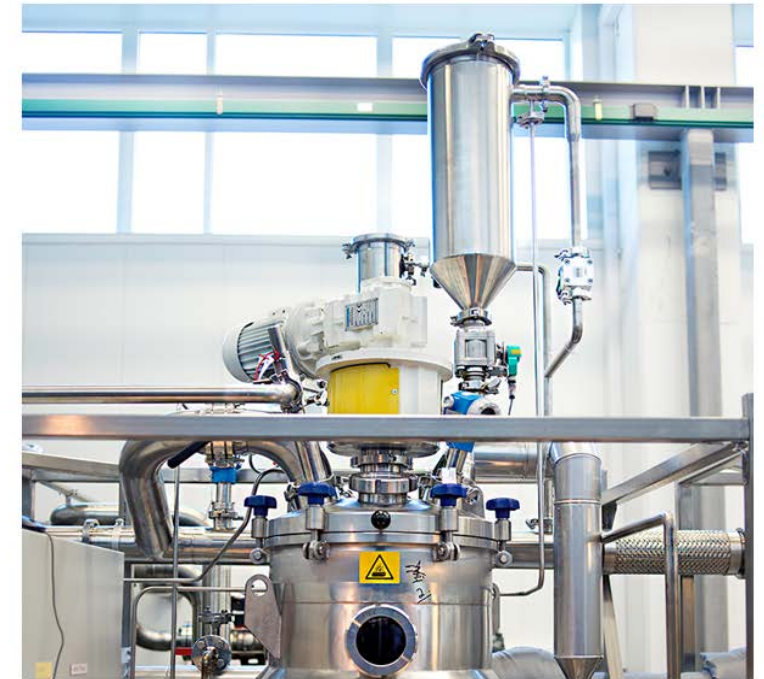
Foto: SINTEFs raffineringsanlegg for marine oljer
