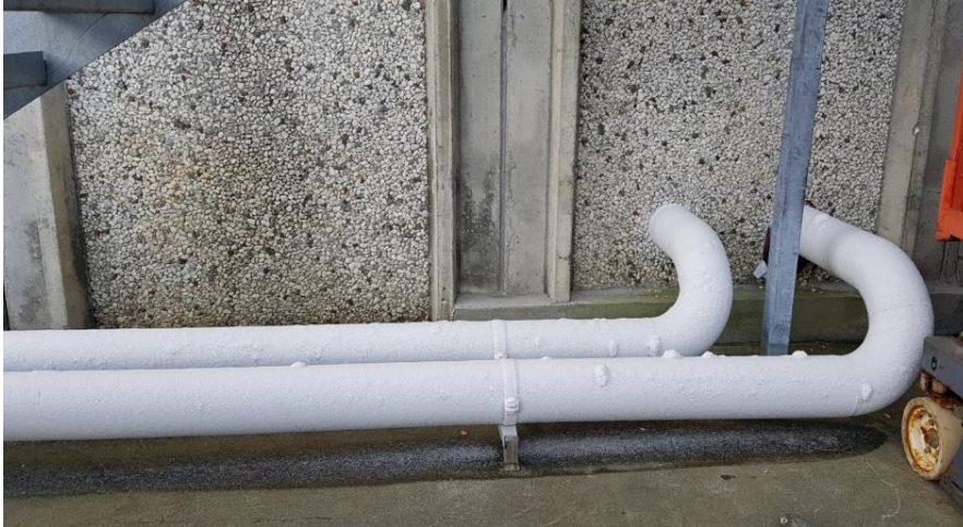
Bilder: Installasjon av kuldemaskineri på Selje. Nederst vises lakerør med gjennomføring inn til fryseenhet.
