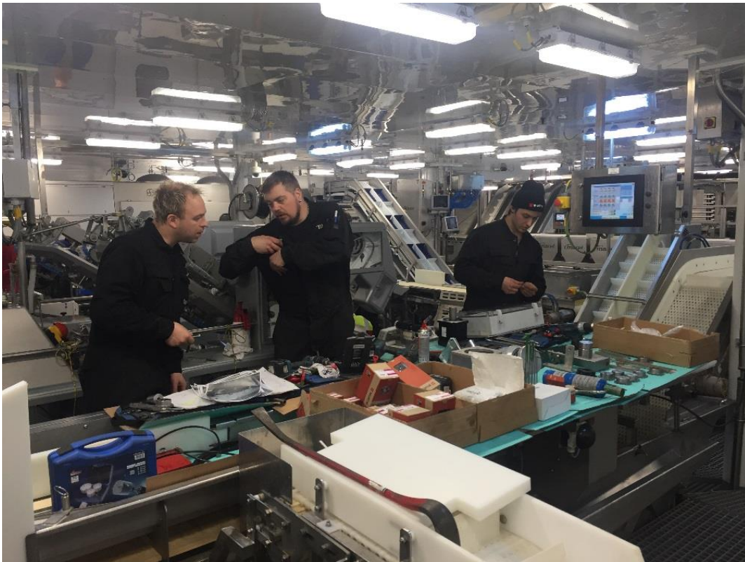
Installering av utstyr i fabrikken om bord F/T «Granit»
