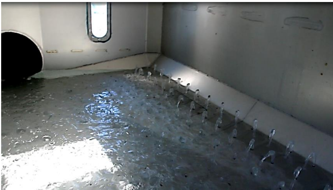
Bilde 8 Vannfordelingen (cirka 1000 liter per minutt) opp gjennom den perforerte (hull hver 10 x 10 cm) dobbeltbunnen. Tanken ble fylt i løpet av 4,5 minutter.
