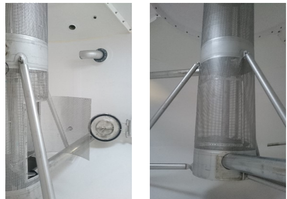
Bilder av en tank innvendig.
