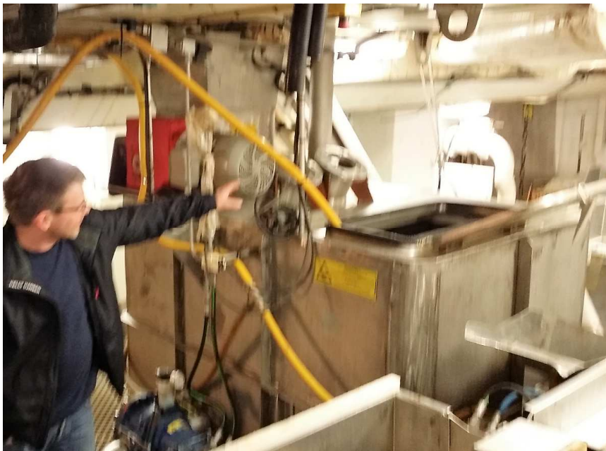
kværnetank i fabrikk
