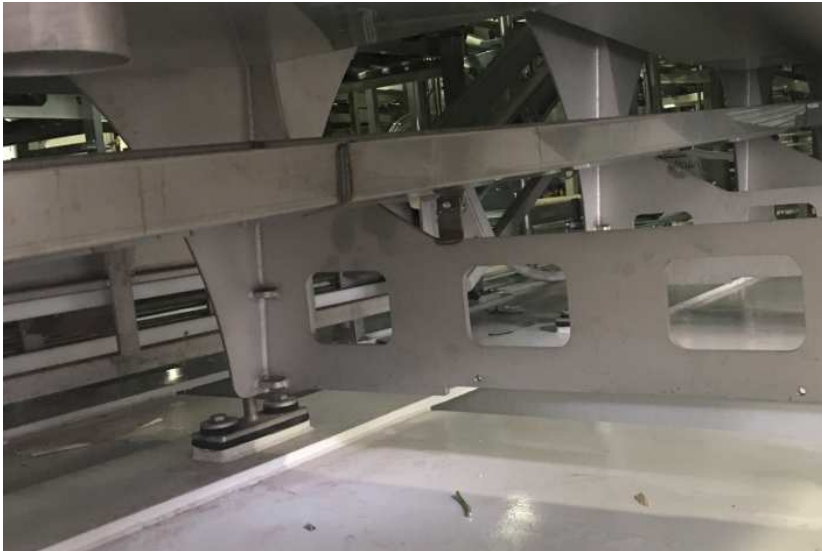
Bilde 4. Forsterkninger i dekket og elastiske klosser under føttene reduserer vibrasjoner.
