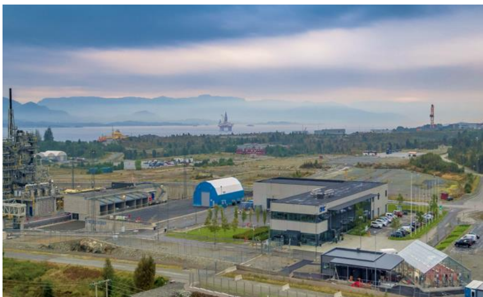
Figur 2. Nasjonal Algepilot Mongstad (nederst til høyre) er fint plassert ved CO2 TCM DA sitt pilotanlegg på Mongstad, og består av et drivhus med reaktorer samt et driftsbygg med prosessanlegg og laboratorier.
