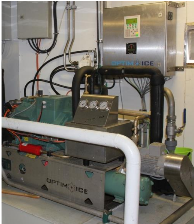
Figur 3. Islurryanlegget om bord i M/S Loran.
