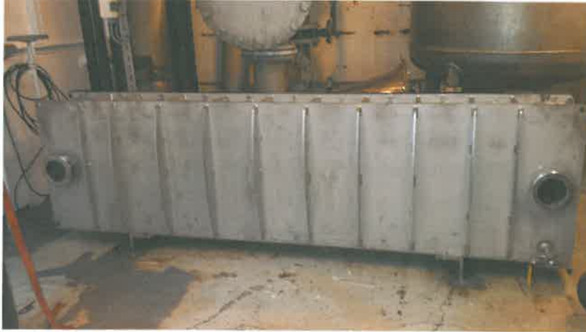
Bilde 1. Fordamper montert i båt.
