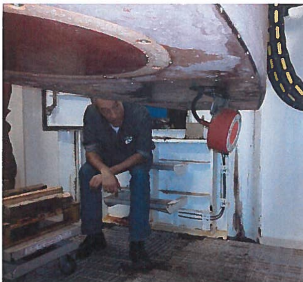
Fig. 2. Inspeksjon av fast svingermontasje, ES200CD, på underside av senkekjølen
