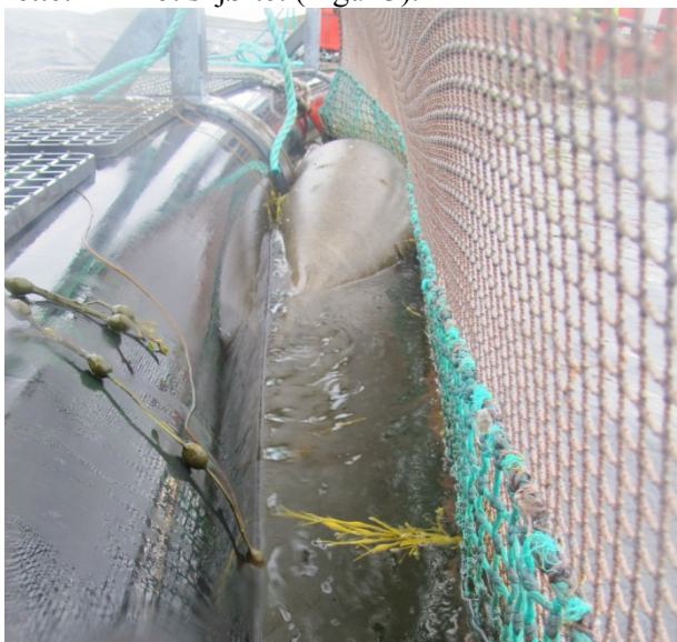
Figur 2 Luftlomme i skjørtet på innsiden av flytekragen.
