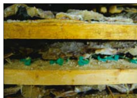
Luftkanaler mellom brett på vogn. (Foto: Claussen, SINTEF)
