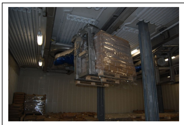
Bilde 12 Kraning til plass i lasterom
