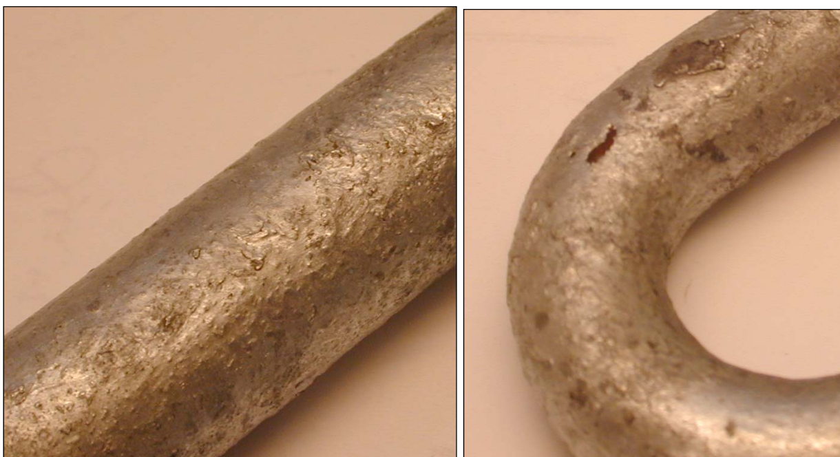
Figur 3 Nærbilder av deler av overflaten på kjettingløkke vist i Figur 2.
