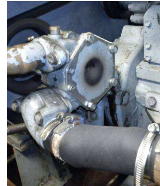
Bilde 7: Pumpe påhengt gir
