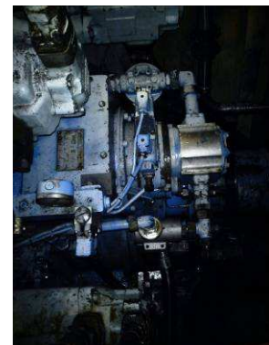
Bilde 4: hydraulikkanlegg påmontert gir hos deltaker
