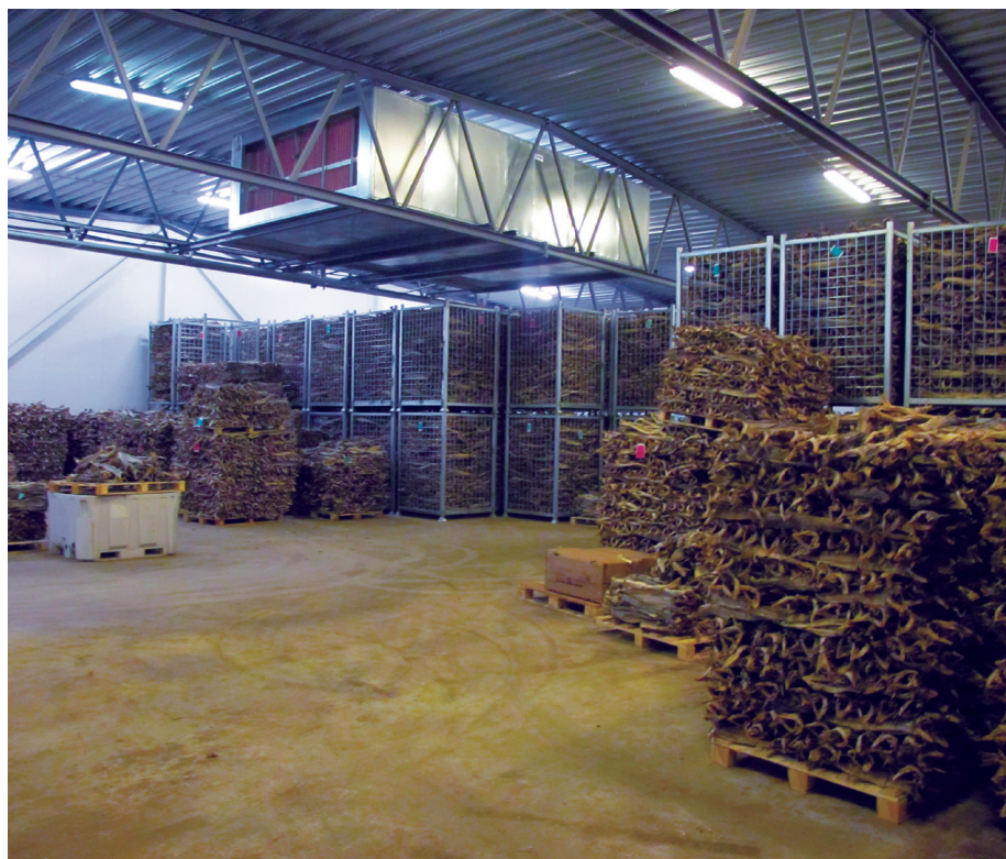
Pilotanlegget for klimastyrt lagring av tørrfisk som er etablert på Værøy.
