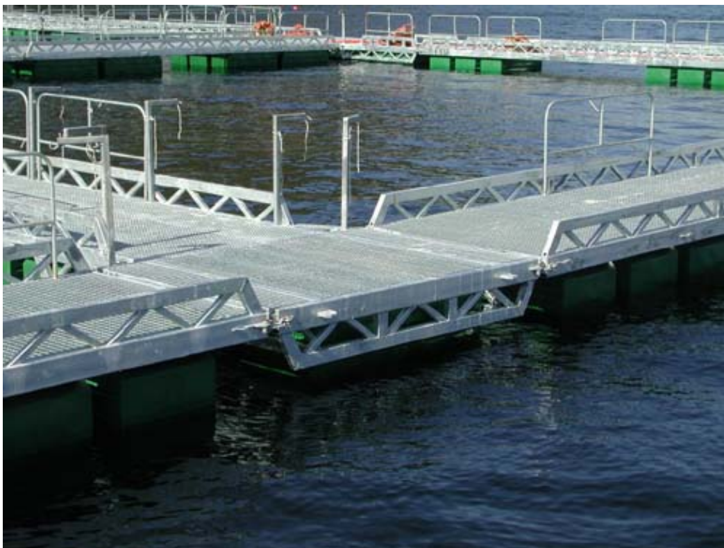
Figur B.1. NM 5000 anlegg med fagverkforsterkning.
