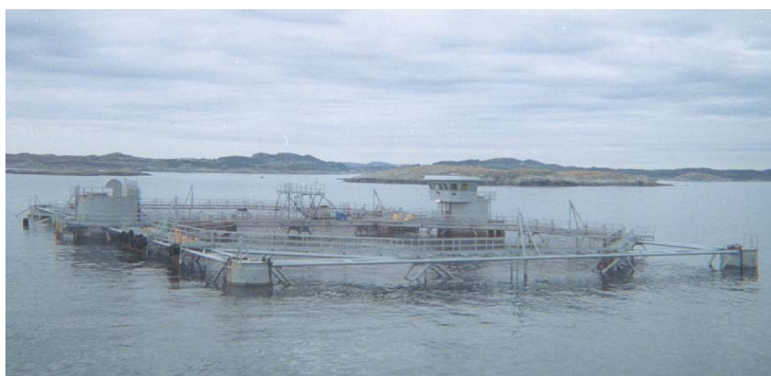
Figur 2.5. Fagverks stålanlegg, Storm.
