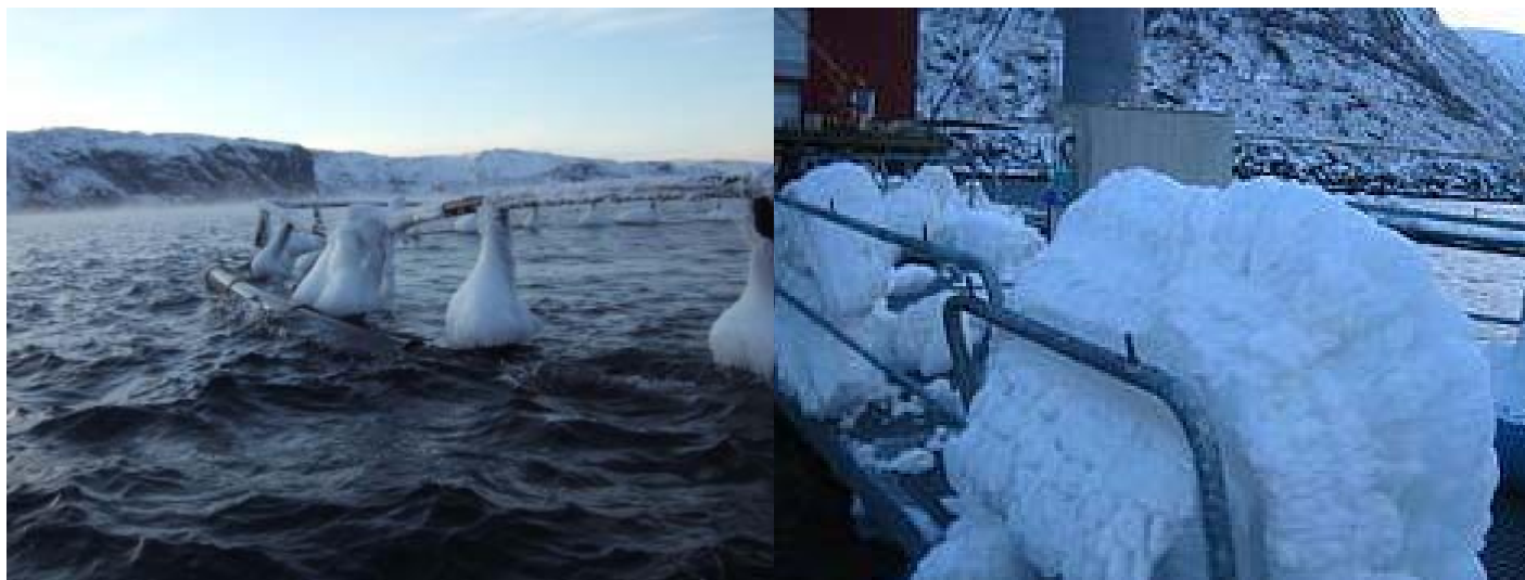
Figur 1. Ising på plast- og stålanlegg. Islast sammen med sterk vind, bølger og strøm, er en kombinasjon som øker risiko for rømming av oppdrettsfisk (Foto: Barlindhaug Norfico AS, Sponfish AS og flextech.no).
