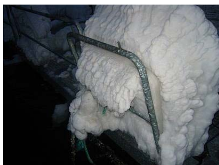
Figur 2 Is på rekkverk, bilde hentet fra http://www.flextech.no .
