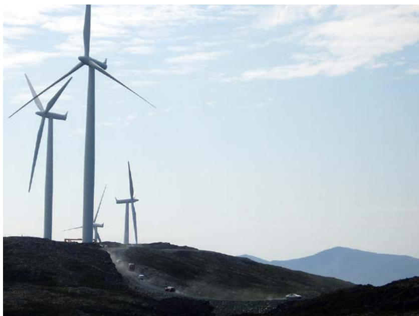
Figur 3.17: Bildet er hentet fra Hitra vindpark. Den vil bestå av 24 vindmøller som hver vil ha en effekt på 2,3 MW. Hvert mølletårn er 70 meter høyt, og rotordiameteren er 82,4 meter. Vindparken får en samlet installert effekt på 55 MW som tilsvarer produksjon av strøm nok til å dekke behovet til ca 7.500 husstander i ett år. Vindparken ble offisielt åpnet 14. oktober 2004.
