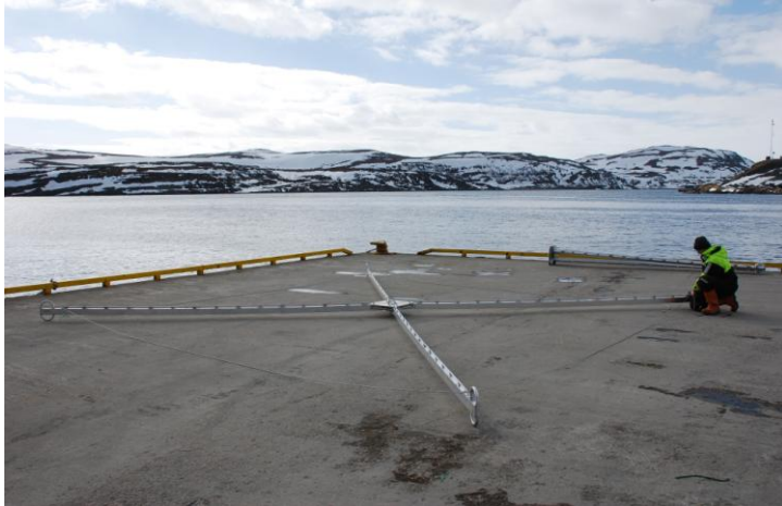
Figur 5. Start rigging av bunnramme for sammenleggbare trampolinebunn.
