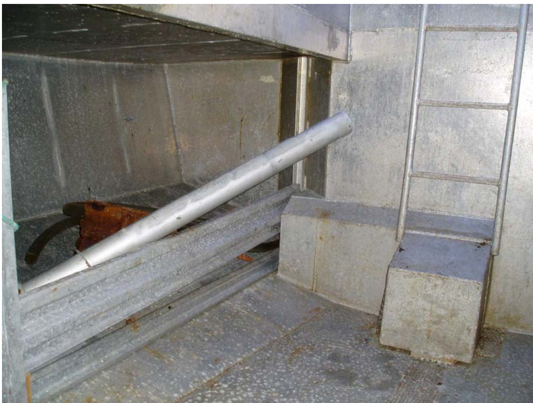
Bilde 15 Lasterommet på "Marna" sett akterover mot SB side og akterskott
