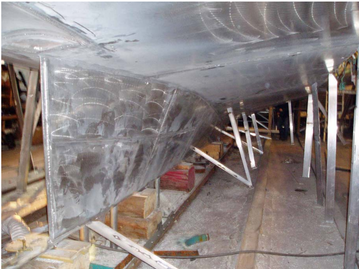
Bilde 2 Medium speed 43 fot - Akterskipet med kjøll og påsveiste hudplater
